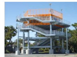
津波避難タワー
