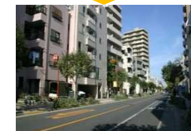
沿道建築物の不燃化 整備後
