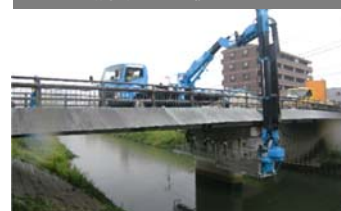
橋梁の点検状況
