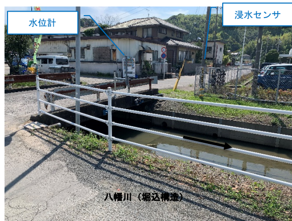
図 4-8：八幡地区水位計、浸水センサ
