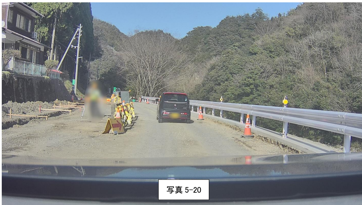
写真 5-20 スマート道路モニタリングカーが取得した劣化箇所の写真
