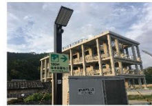
津波避難タワー
