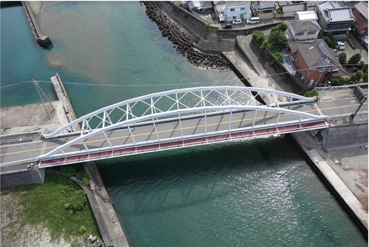
図表 45 ドローン撮影したすさみ大橋の写真（3枚目）
