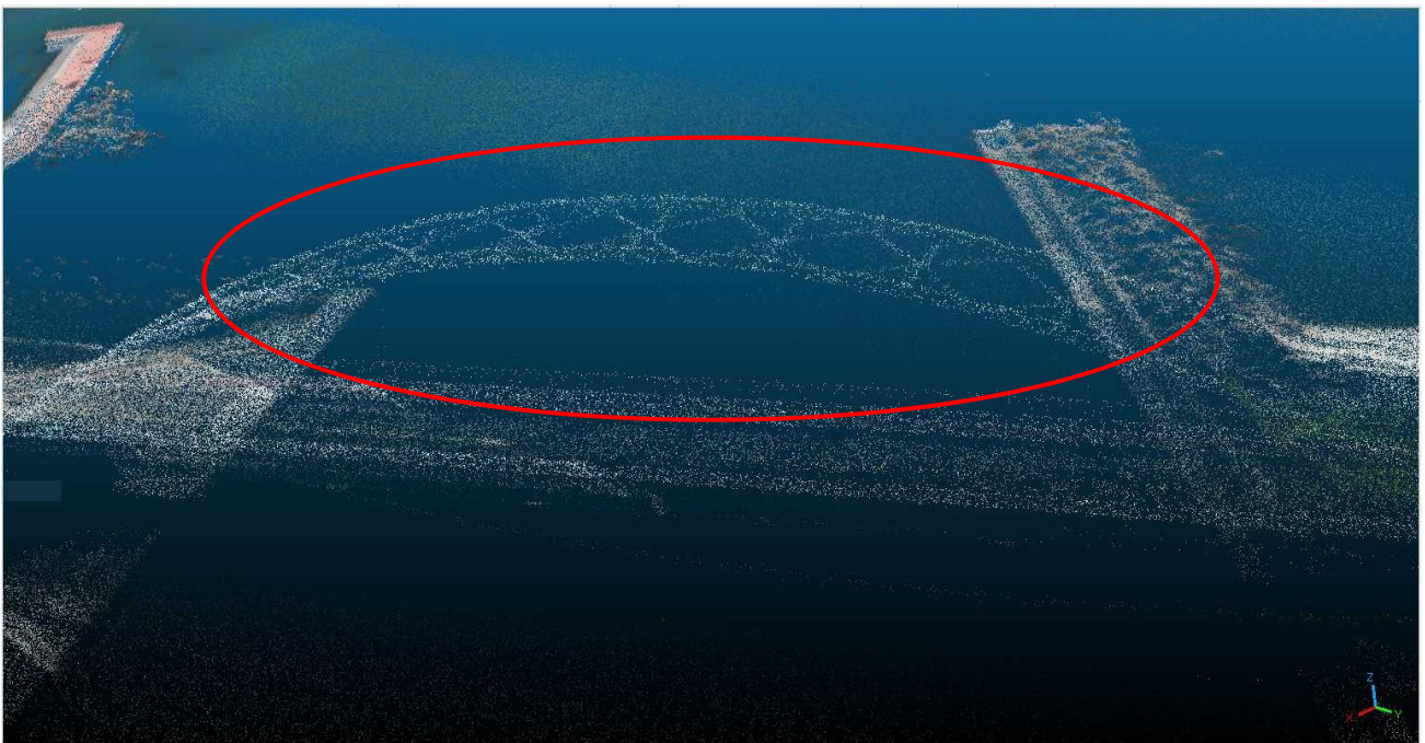
図表 38 3次元地図データ (Zenmuse L1にて計測した3次元地図によるすさみ大橋) 赤枠内では橋梁部分、および電線の詳細確認が難しい
