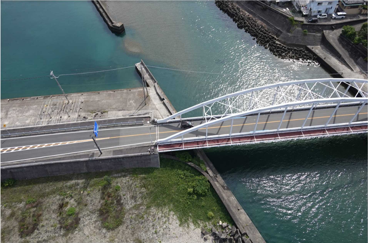
図表 45 ドローン撮影したすさみ大橋の写真（1枚目）
