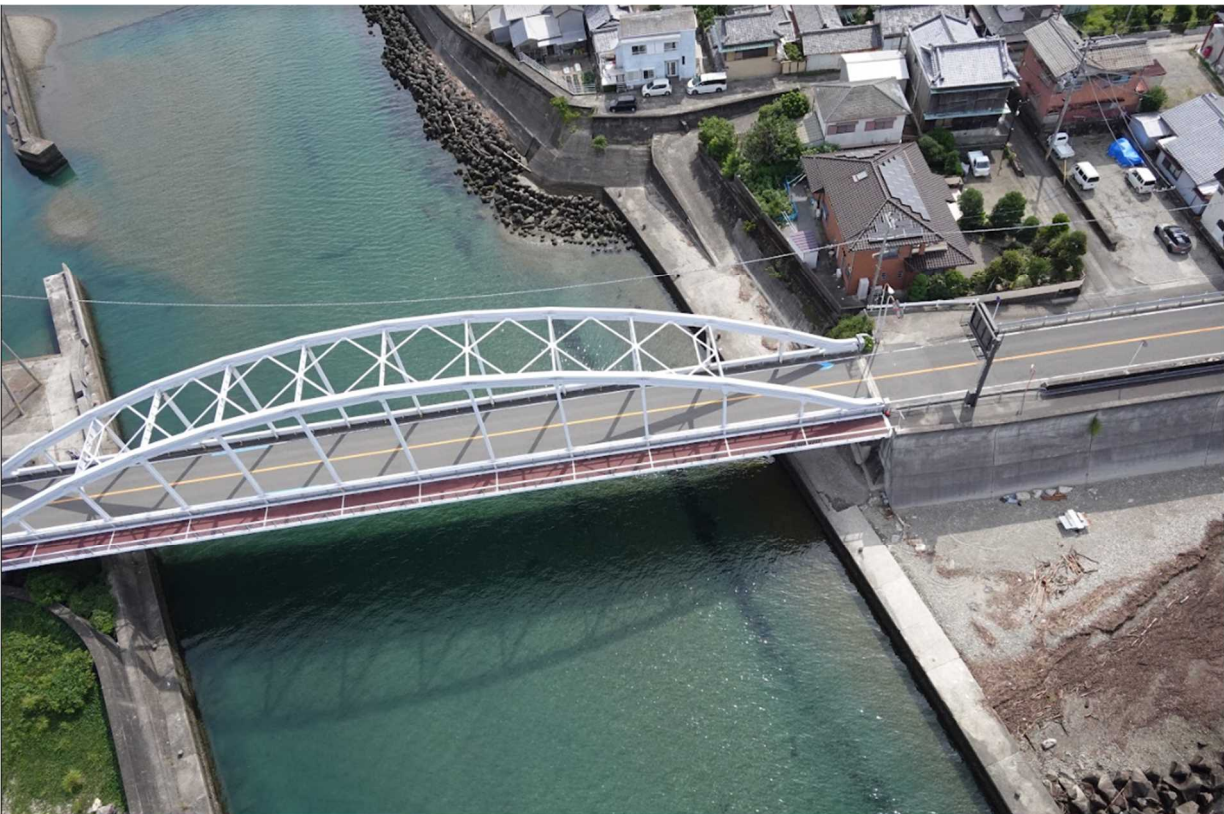
図表 45 ドローン撮影したすさみ大橋の写真（4枚目）
