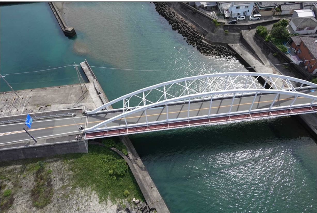
図表 45 ドローン撮影したすさみ大橋の写真（2枚目）
