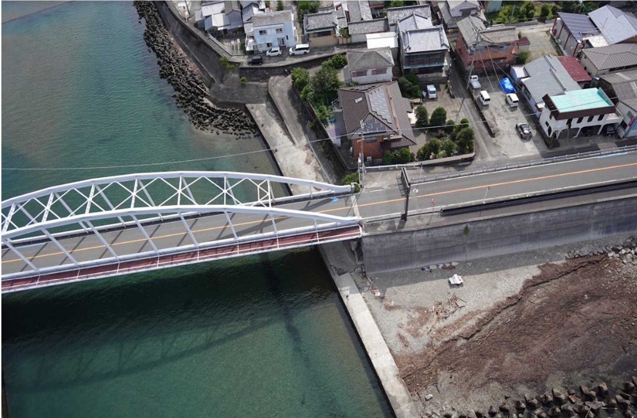
図表 45 ドローン撮影したすさみ大橋の写真（5枚目）
