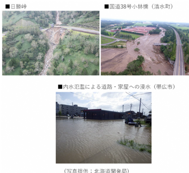
図 7 台風10号 被害状況 (H28)
