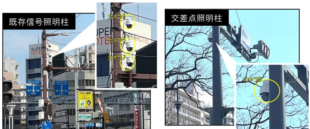
図4-1-5 車両用AIカメラの設置の様子
