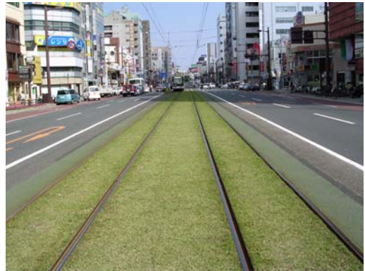
図4 - 58 . 既設の軌道敷の芝生化 (高知市 土佐電鉄)
