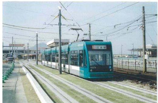
図4 - 59 . 樹脂固定軌道 同時に芝生軌道化した例 出典：広島電鉄資料
