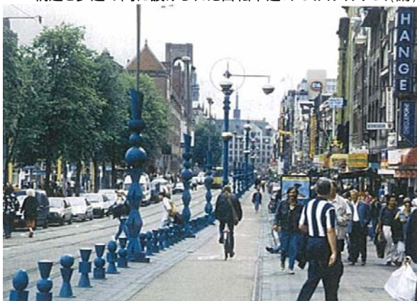
LRT軌道と歩道の間に設けられた自転車道：アムステルダム(蘭)
