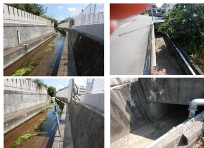
図 設置候補地写真（左：候補（1）、右：候補（2））
