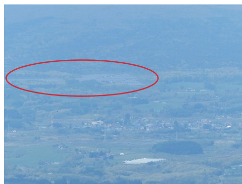
写真2 太陽光発電設備アップ
