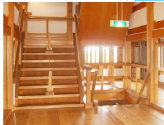
三階櫓（天守閣）は昔ながらの工法を用い、補強金具は使われていません。
