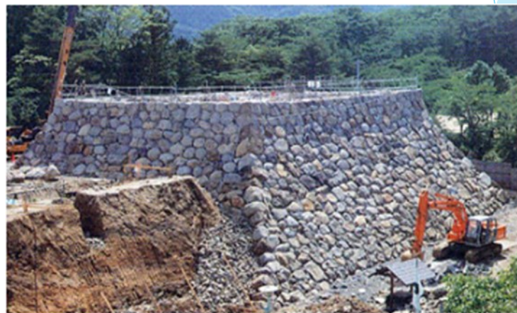
天守閣の石垣は、「野づら積」で石が積まれ、細かい部分は手作業で石が詰め込まれた。 蔵王山系の安山岩など約3,000トンの石が使われた
