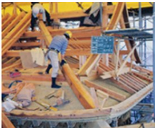
数百年の年月に耐え得る城にするため、木材にこだわり、宮大工の手によって組み上げられた。
