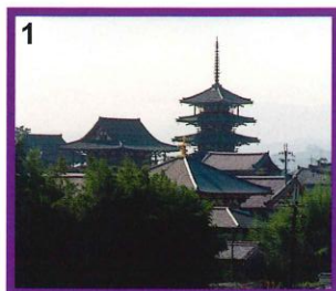
1 奈良県 生駒郡斑鳩町 法隆寺地域の仏教建造物 (世界文化遺産) 古都保存法の古都指定都市
