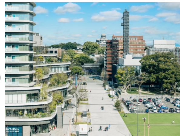
整備後（R3.11撮影）
