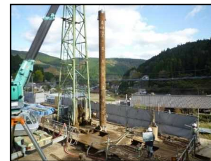
網状鉄筋挿入工
