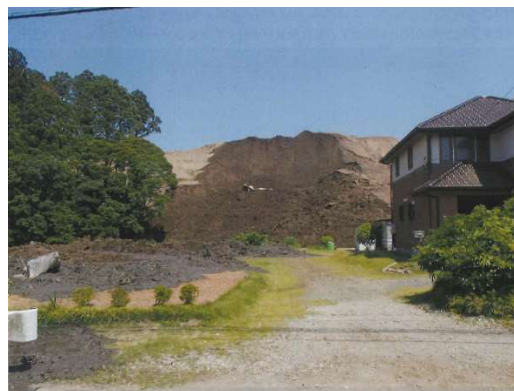
図 3.1 千葉県香取郡多古町の盛土の崩落の様子
