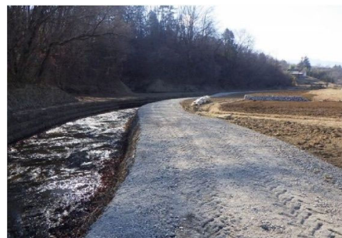
応急対策工事後（流出土砂の撤去）
