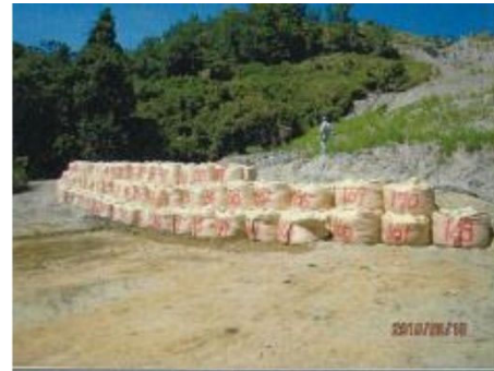
応急対策工事後（大型土嚢）
