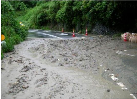
崩落発生後（国道への土砂流出）
