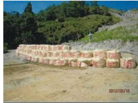
応急対策工事後（大型土嚢）
