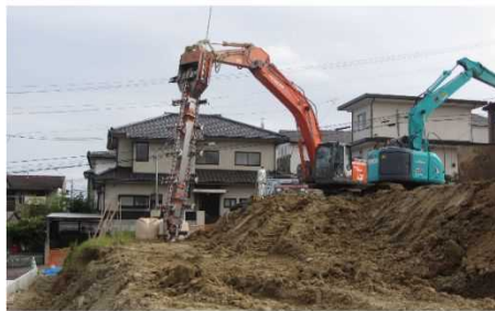
図参 5.1.2 固結工法（中層混合処理工）の施工機械（N地区の例）
