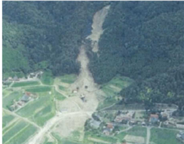
図参 1.1.2 盛土の崩落により流出した土砂が土石流化した様子
