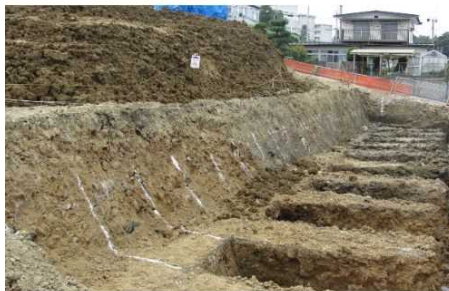
図参 5.1.3 固結工法（中層混合処理工）の施工状況（N地区の例）
