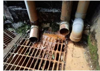
(d) 水抜き穴からの湧水 (鉄分を含むことを示唆する赤褐色物質が沈積)
