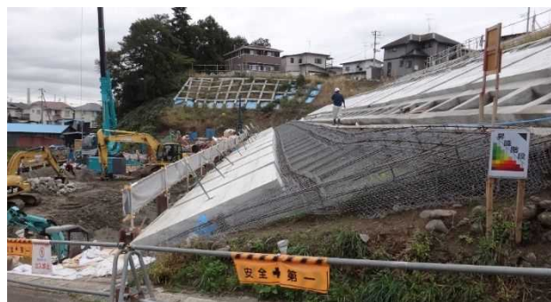
図参 5.1.8 グラウンドアンカー工法（現場打ちのり枠工+グラウンドアンカー工）の施工状況（NK地区の例）
