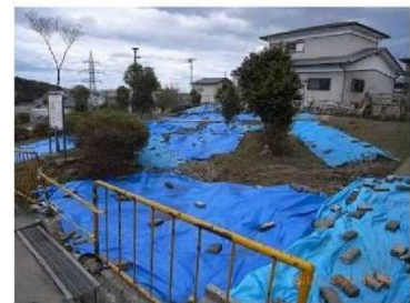
図参2.2 局所的なり面崩壊
