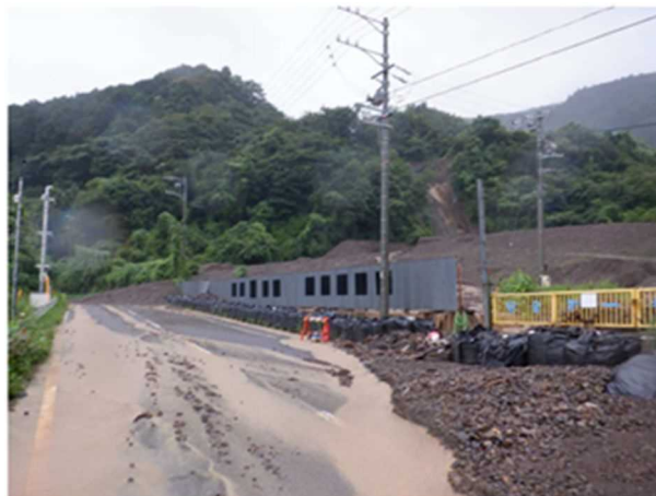
図参 3.2.1 採石場跡地で発生した土砂流出の様子
