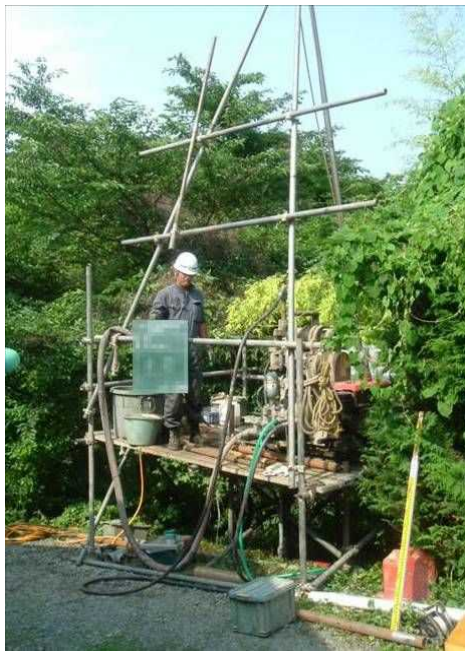
図参 7.4.1 調査ボーリング実施風景
