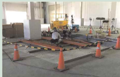
工事エリアの区画を設定して作業
