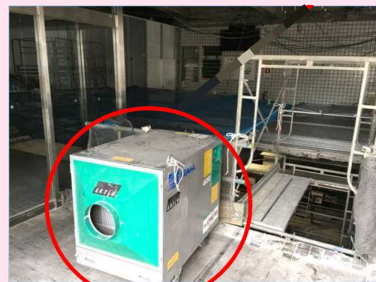
集塵機を設置し室内の換気を実施
