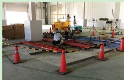
工事エリアの区画を設定して作業
