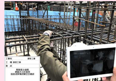
Webカメラを利用した遠隔検査
