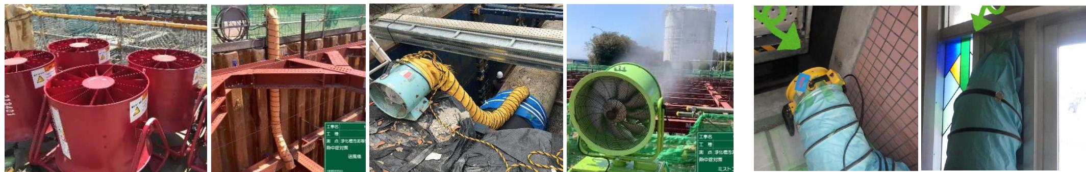
送風機により通気性を確保するとともに、ドライミスト発生装置等も併用
