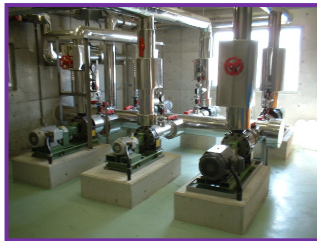
送水ポンプ(1階)
