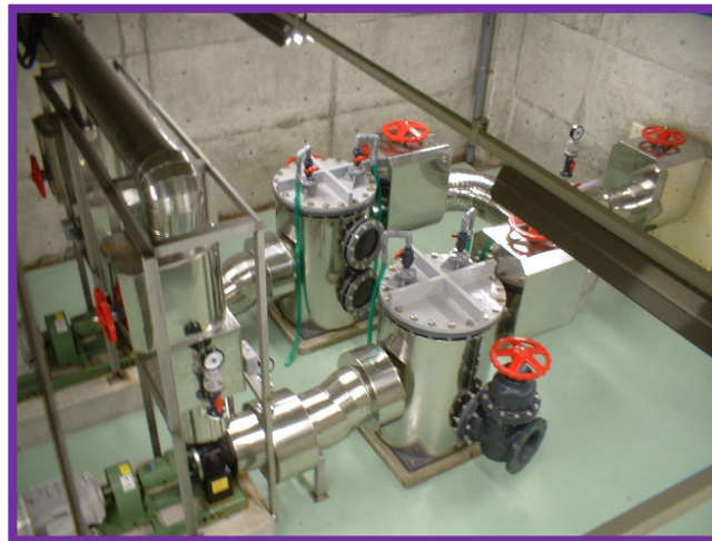
取水ポンプ(地下1階)
