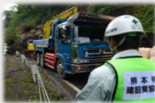
道路啓開(倒木・土砂の撤去)
