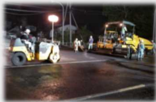
通行不能の交差点での応急工事
