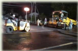
通行不能の交差点での応急工事
