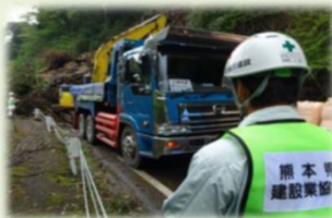
道路啓開(倒木・土砂の撤去)
