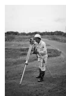
③建設現場のポートレート
