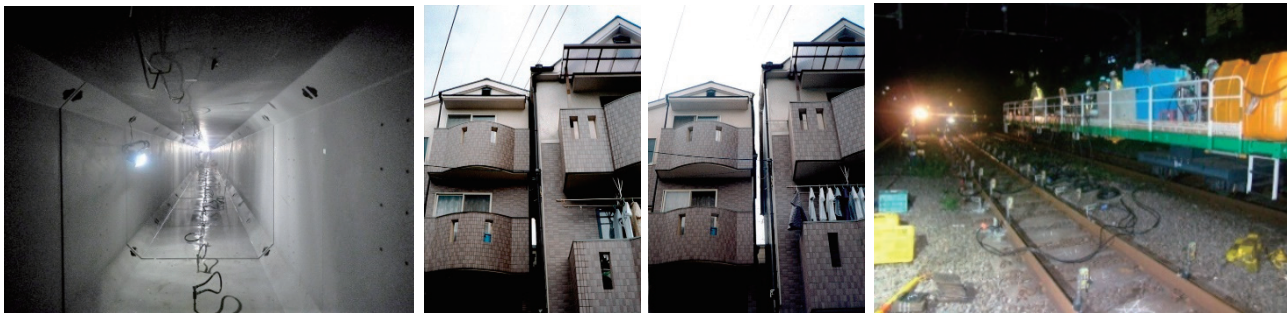
ボックスカルバート 一般住宅 施工前 施工後 JR 軌道
