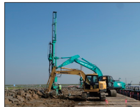
護岸工事の施工事例
