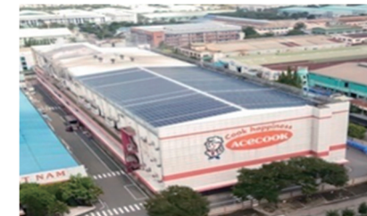
エースコックベトナム太陽光発電設備
