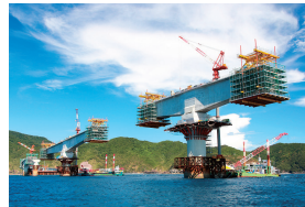
張り出し架設
