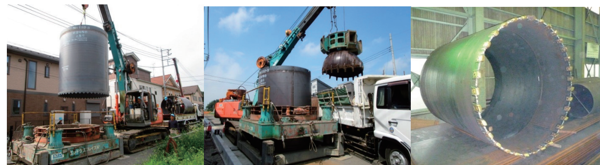
超硬ビット取付により礫層での 施工も可能
