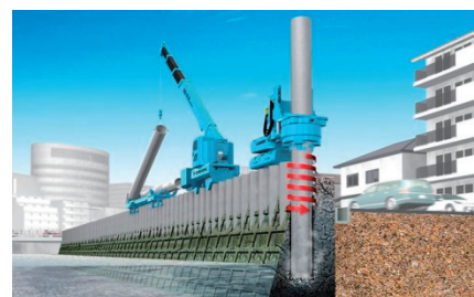
既存護岸を撤去せずに護岸新設
