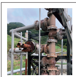
神奈川県箱根町 蒸気泉メンテナンス
