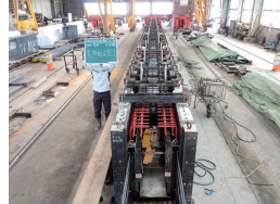
プレテンション桁製作
