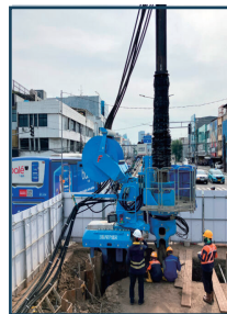
インドネシア下水道整備
