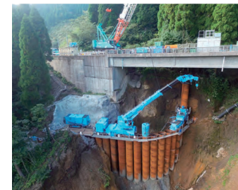
災害復旧工事
