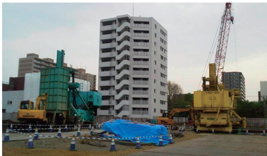
地中連続壁工事
