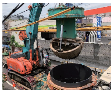
φ3000mm 立坑築造工事
