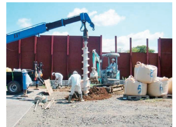
SST 工法の施工状況
