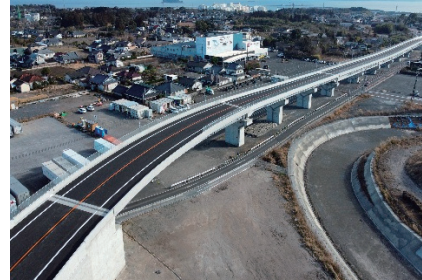
町原大橋(P4～P9) 橋長 195m PC 5 径間連結コンボ橋
