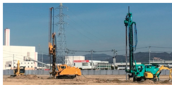
スリーエス G 工法施工風景
