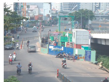
ホーチミン施工状況
