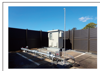
三重県志摩地中海村温泉 掘削工事・設備工事
