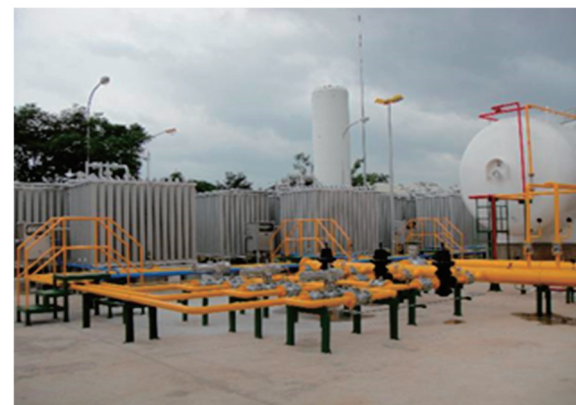
LP ガス供給設備(ベトナム・ホーチミン) 50t タンク 1,500kg/h 空温式気化器ほか
