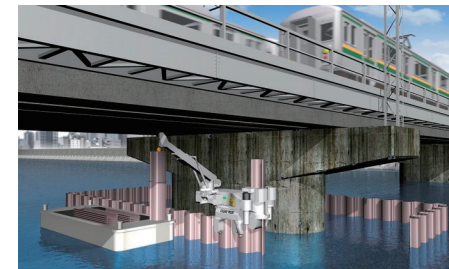
橋梁桁下での橋脚補強工事
