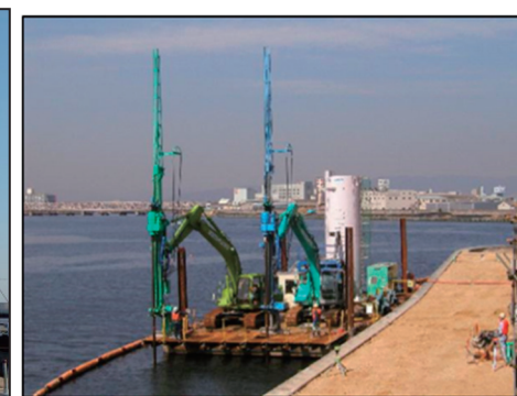
台船からの施工事例
