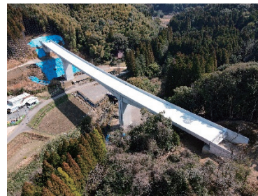
阿久根高尾野 1 号橋 橋長 164m PC3 径間連続ラーメン箱桁橋
