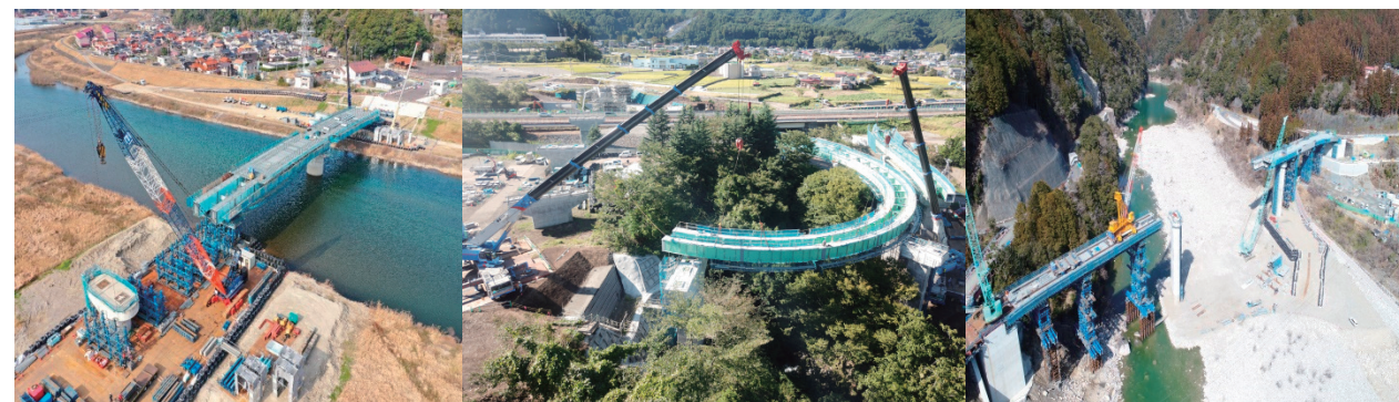
新高角橋橋梁上部工事
