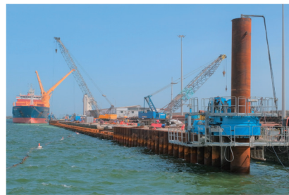
船の接岸や荷役を阻害せず施工が可能 （セネガル）
