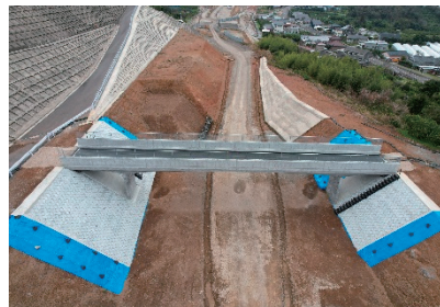
米之津川橋外 橋長 18.65m PC 斜材付変形 \pi 型ラーメン橋
