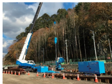
岩手県災害復旧工事（鋼矢板圧入）
