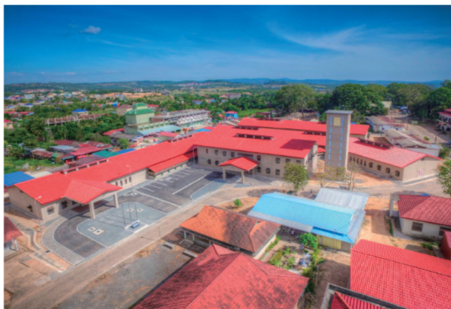
ドローン撮影による全景（奥の赤瓦全部）
