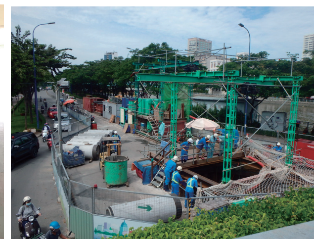
VN ホーチミンでの施工状況
