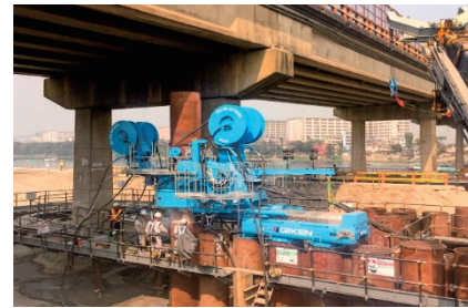
空頭制限下で橋梁基礎工事が可能 （バングラデシュ）
