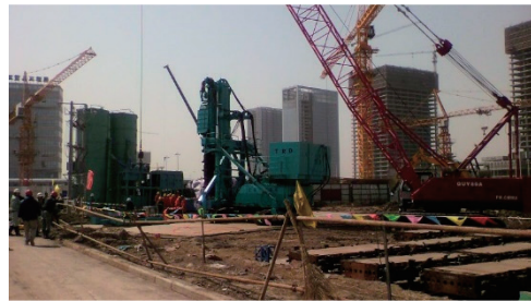
中国・天津 地中連続壁工事
