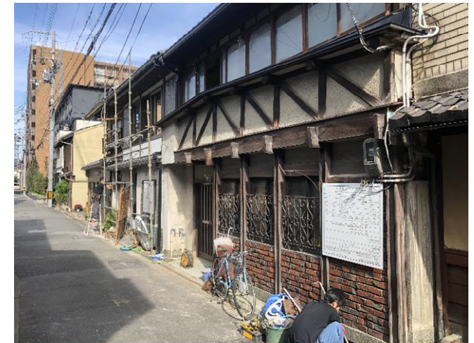
建物外観（改修前）
