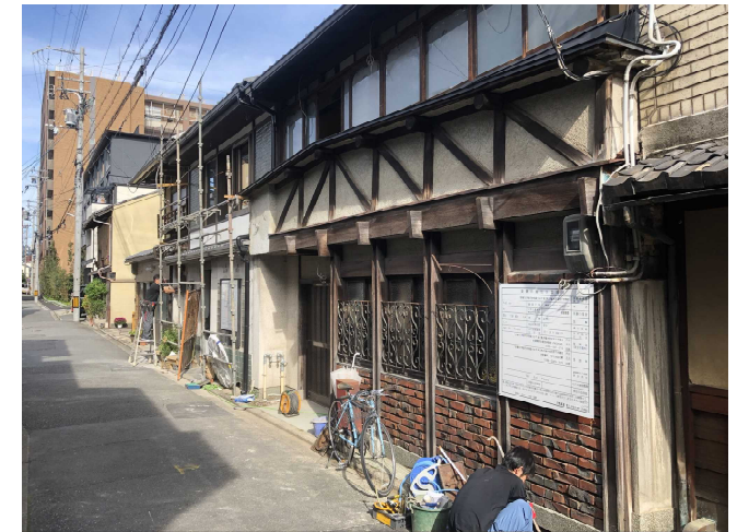
建物外観（改修前）
