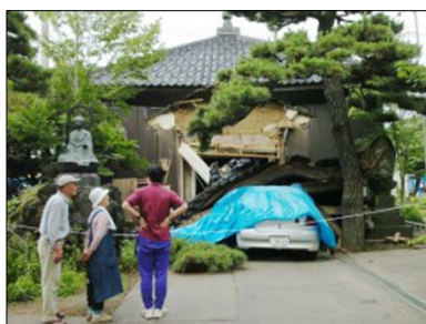
【被災した閻魔堂の様子】
