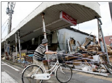
【全壊した建物が連続】
