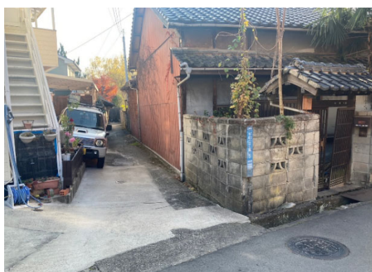
(a) 狭隘道路に面した空き家
