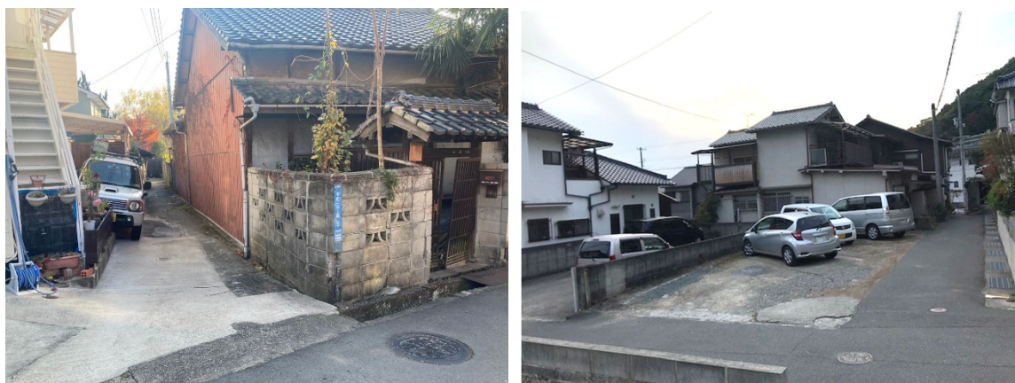
写真 1 地区内の狭隘道路と低未利用地
