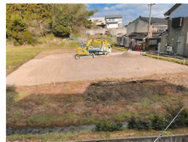
造成工事の様子
