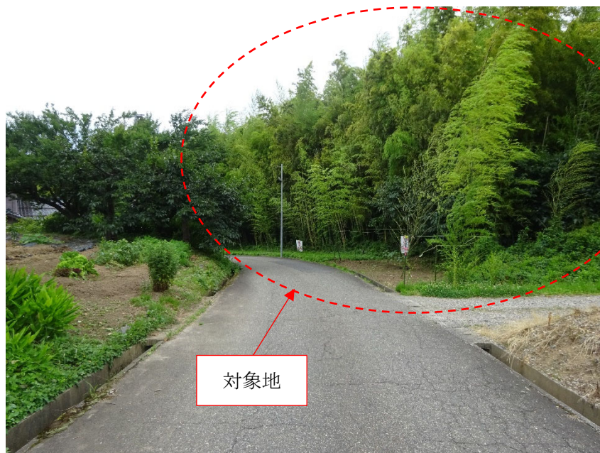
図表 7 地域（土地）の現況写真（令和4年6月30日撮影）
