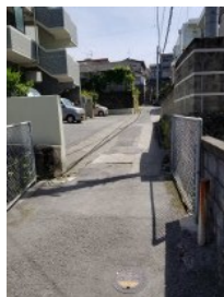
幅員2.3mの法外道路
