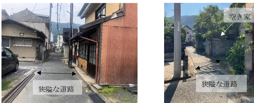
写真1 地区内の狭隘道路
