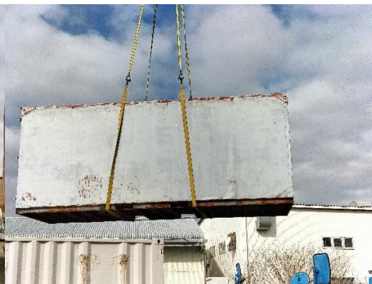
図表 13-6 コンテナ移動工事中 2
