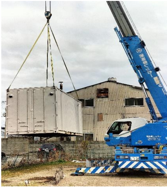
図表 13-7 コンテナ移動工事中 3
