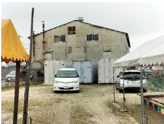
図表 13-1 コンテナ移動工事前
