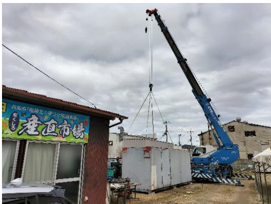
図表 13-5 コンテナ移動工事中 1
