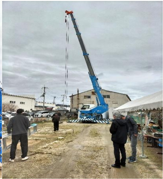
図表 13-8 コンテナ移動工事中 4
