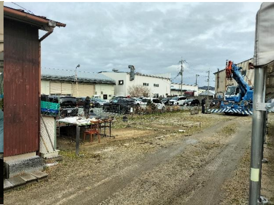
図表 14-16 整備工事のため撤去されたテント
