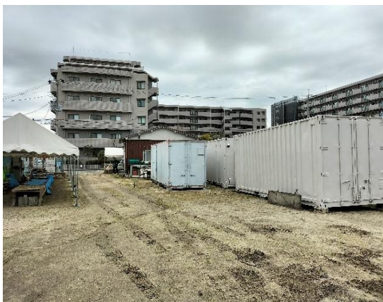
図表 13-3 コンテナ移動工事後（仮移動）
