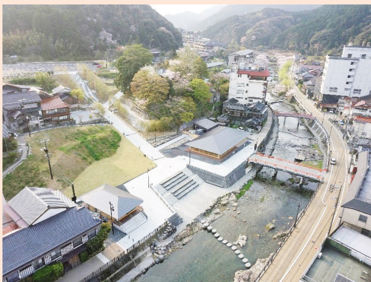
エリア全体の様子
