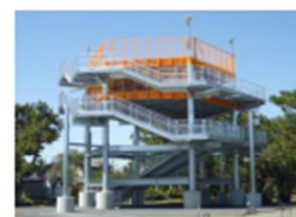
津波避難タワー
