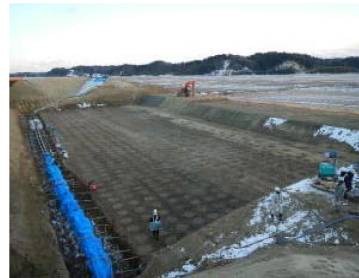
SCP工法施工完了事例 1)
