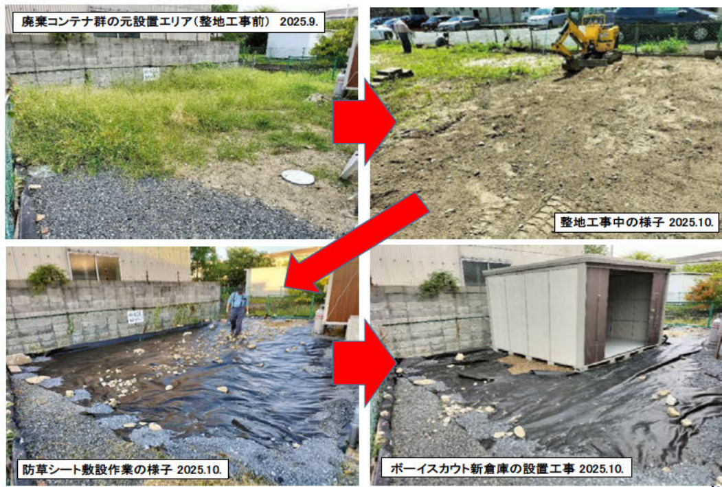
図表 11 ボーイスカウト新倉庫の再配置、設置工事の実施
