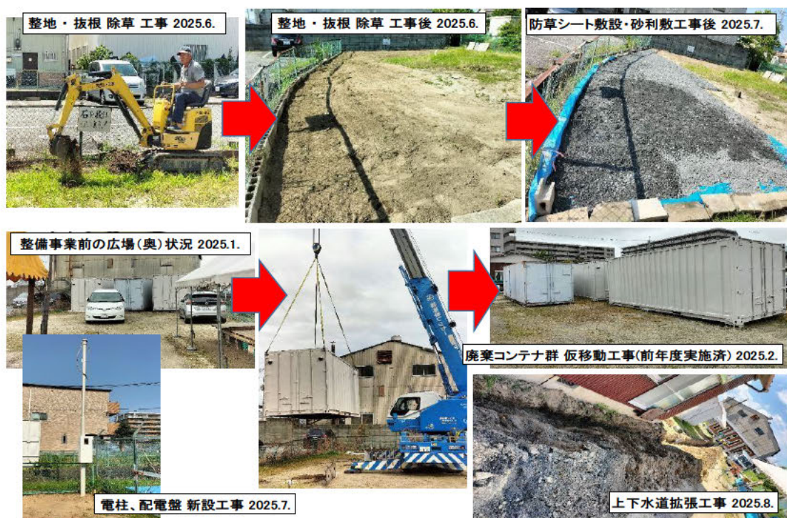
図表 7 インフラ基盤整備・拡張工事の様子
