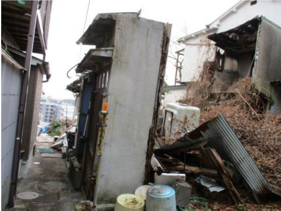
建物の残骸が隣接地にいつ倒れてきてもおかしくない状況
