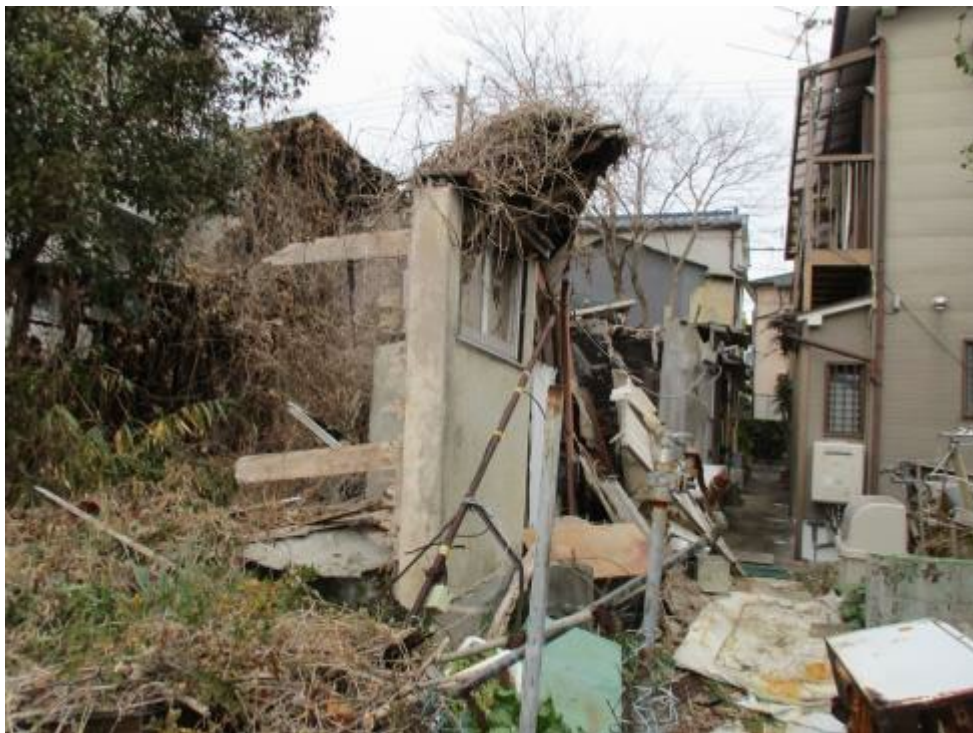
不法投棄、枯れ枝、落ち葉で自然発火の危険性をはらむ
