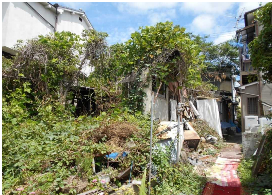
図表 7 建物残骸と残置物
