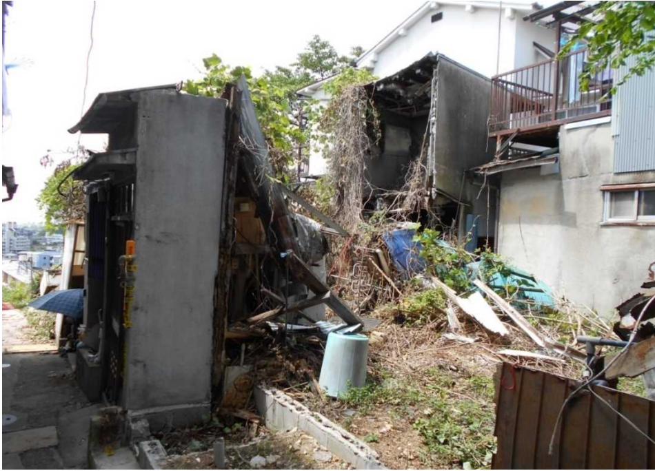
図表 6 建物残骸と残置物
