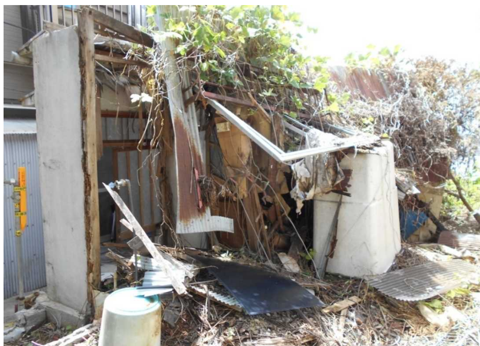
図表 5 建物残骸と残置物
