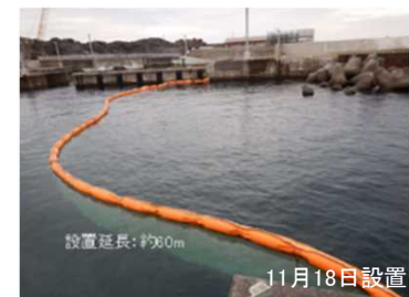
神津島港のオイルフェンス設置状況 設置延長: 約900m 11月18日設置
