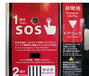
非常通報装置の設置例
