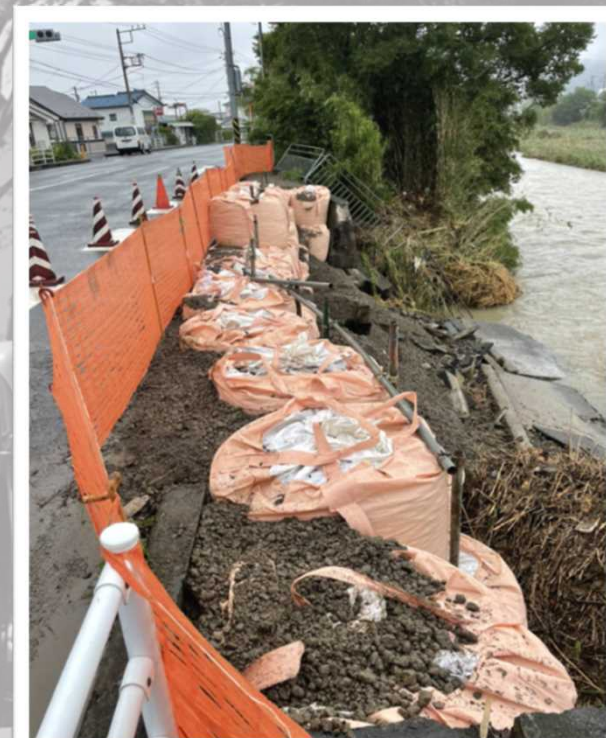
崩落した現場
