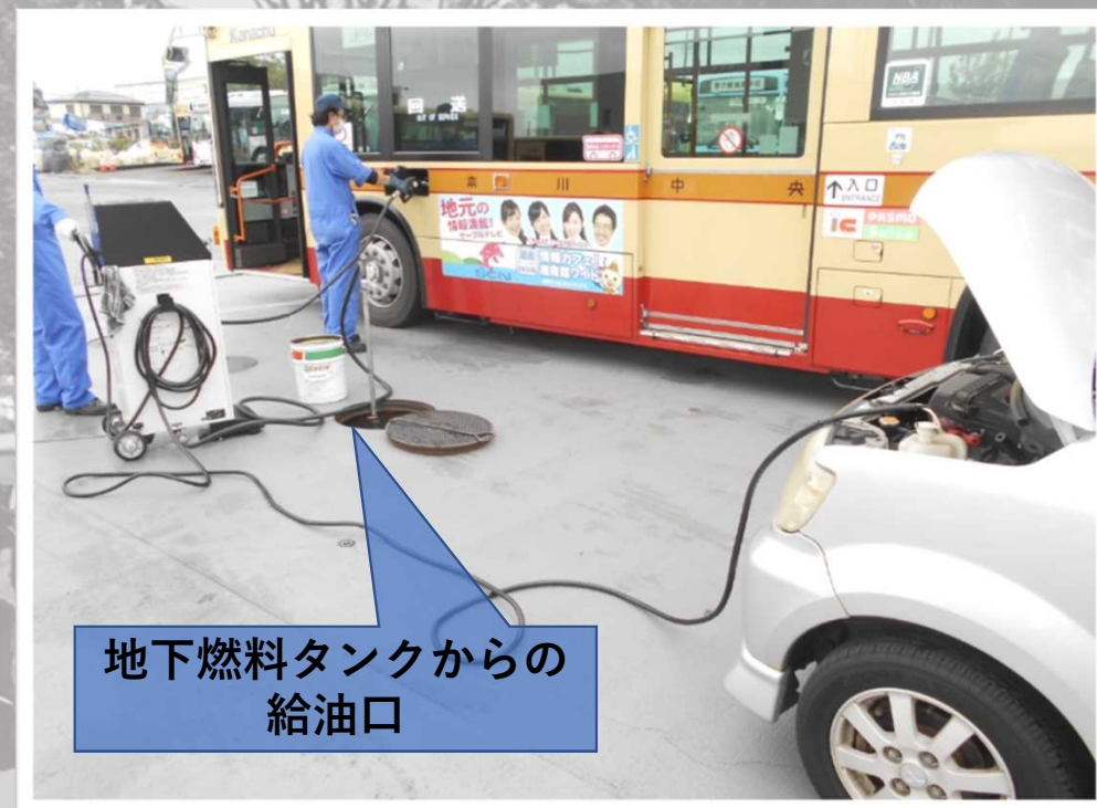
【給油機へ自家用車から給電】
