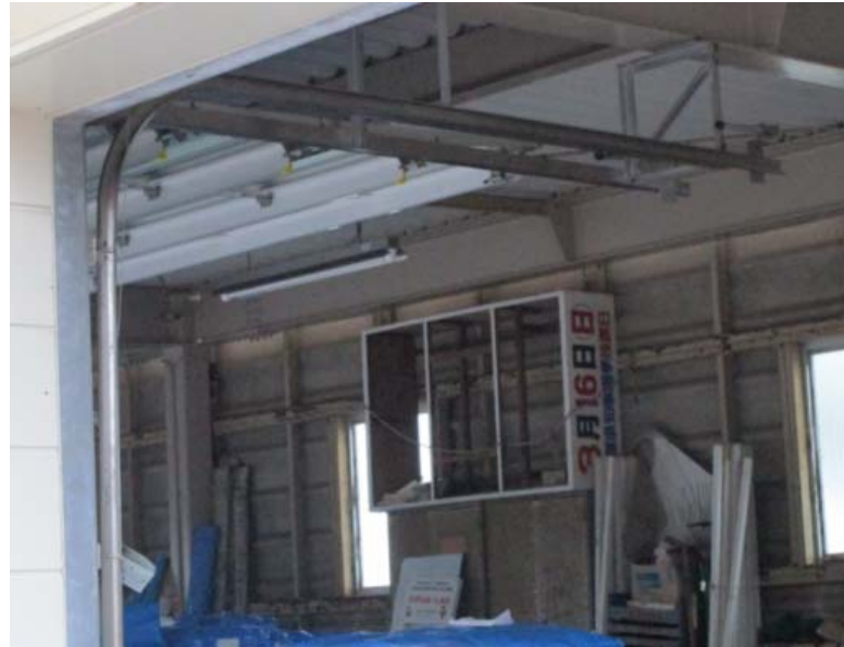
※パネルが飛散、変形したオーバースライディングドア
