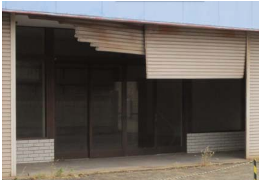
※中柱からスラットが外れた軽量シャッター
