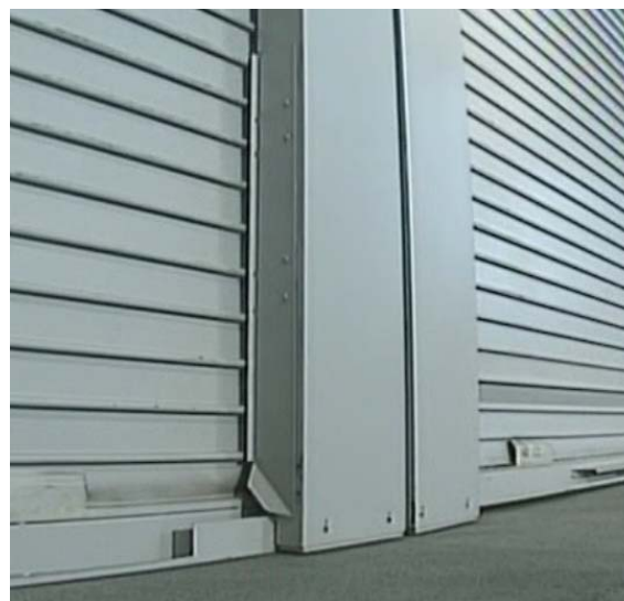
④ 先に降下した中柱に案内されて、 片側の中柱が降下し嵌合する
