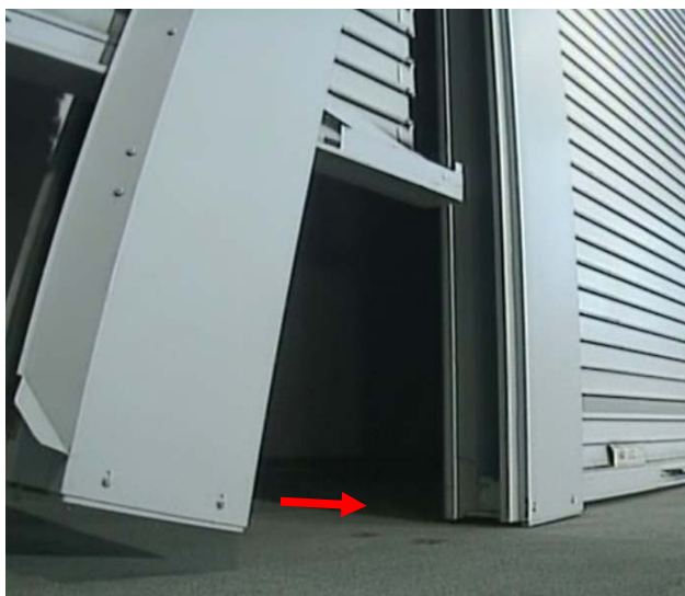
④ 先に降下した中柱に案内されて、 片側の中柱が降下し嵌合する
