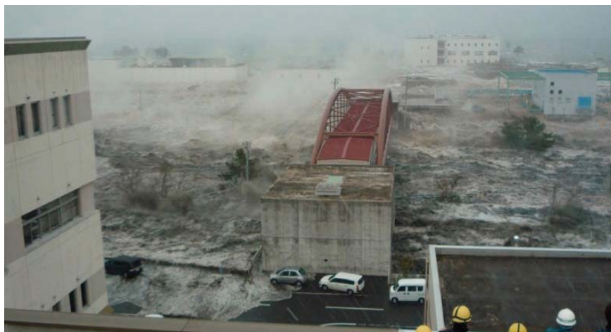
津波に襲われる南蒲生浄化センター
