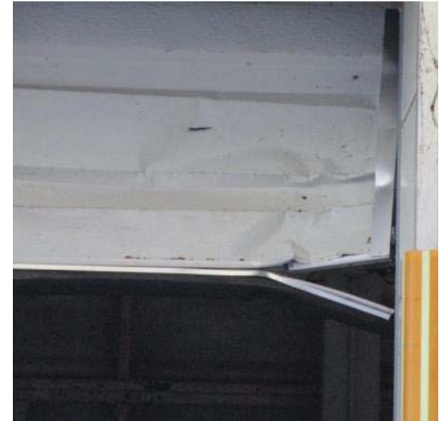
※パネルが飛散、変形したオーバースライディングドア
