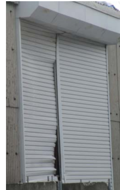
※中柱からスラットが外れた軽量シャッター
