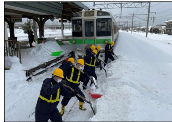
JR北海道の除雪作業 （令和4年2月の札幌圏大雪）
