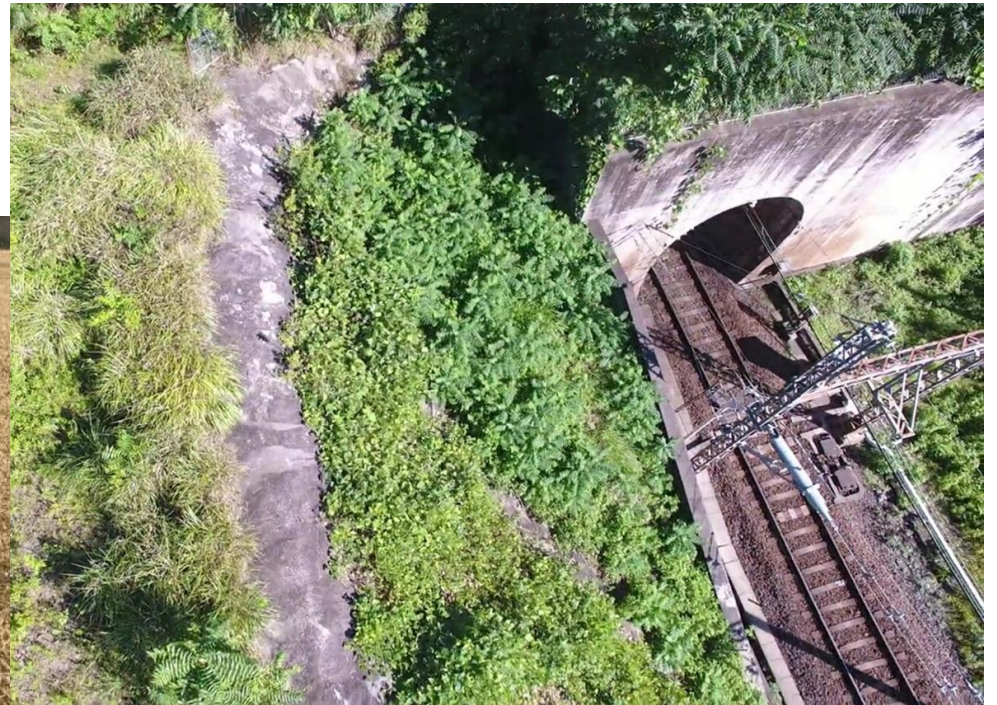
寒谷トンネル
