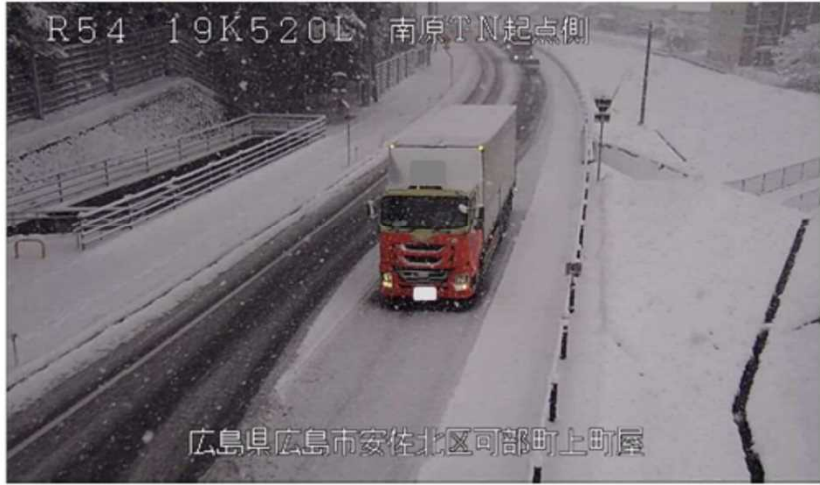
国道54号 広島県広島市安佐北区(令和4年12月19日)
