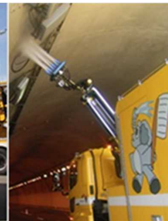
《トンネル灯具清掃での使用状況》
