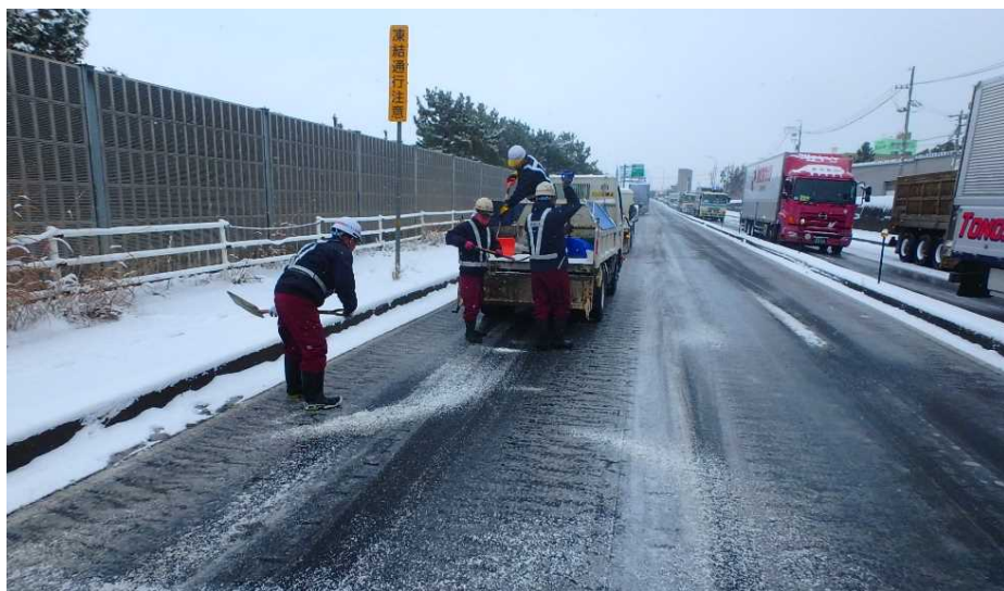
凍結防止の薬剤を手撒き散布
