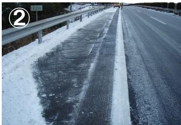
非常駐車帯を確保
