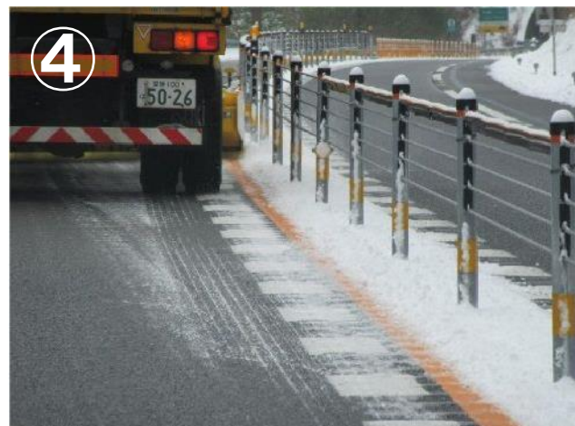
突起型路面標示部の除雪 (黄色外側線が概ね見える状態を確保)
