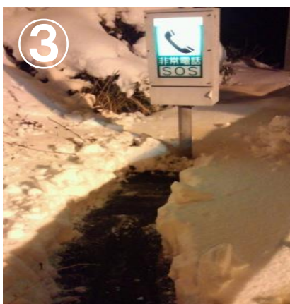
非常電話への進入路を確保 (非常駐車帯から非常電話まで人が歩行出来る状態を確保)
