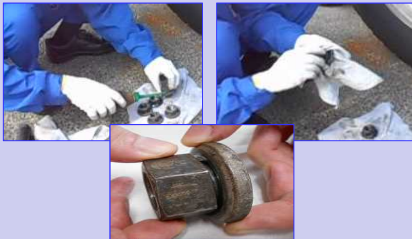
劣化したナットの点検・交換
